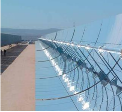
الشكل (5-5) مجمع شمسي ذو مجرى قطعي مركز بمرآة دورانية
